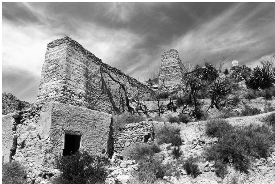
7. Las estructuras de los Molinos 12 y 13.
