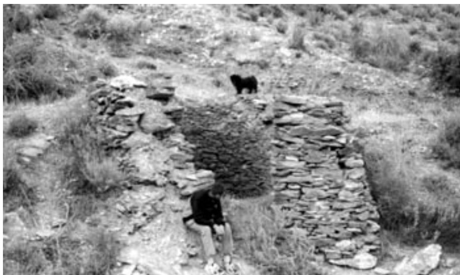
Lám. 5.- Restos de calera para la obtención de cal a partir de piedra caliza en las proximidades de Adra (foto: M. Paracuellos).
